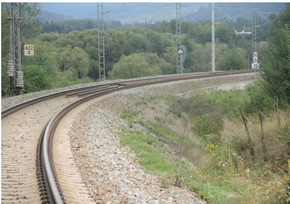
Obr. č. 1: Neproměnné návěstidlo rychlostník N s návěstí „Traťová rychlost“ s číslicí „30“, umístěné na společném sloupku s neproměnným návěstidlem s návěstí „Konec platnosti rychlostníků NS“, viditelné na vzdálenost 163 m.
